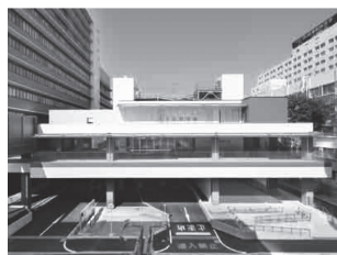
デッキ棟 東側外観
