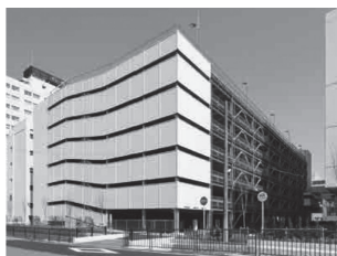
立体駐車場 南西面外観
